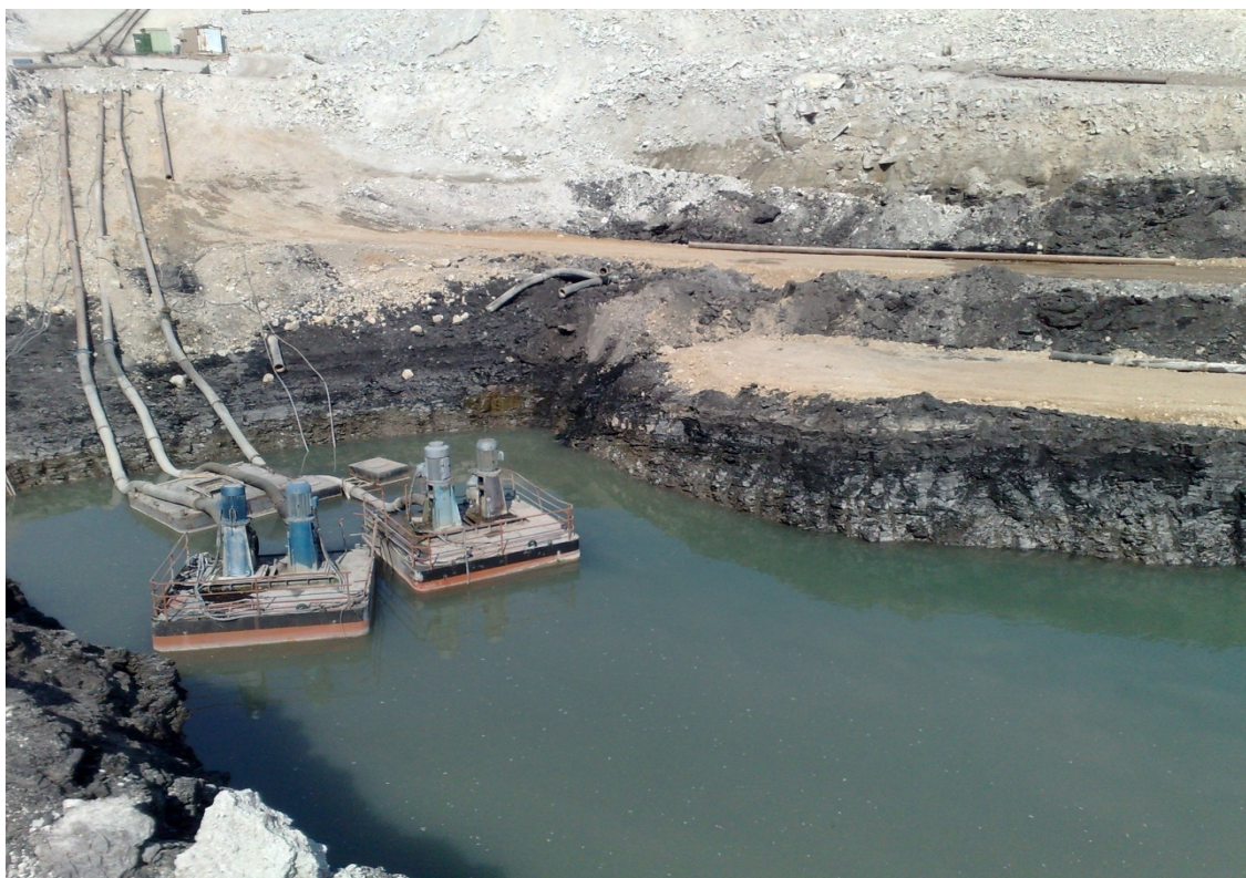
Slika br. 3.4.2/1 - Glavni vodosabirnik na PK Potrlica
