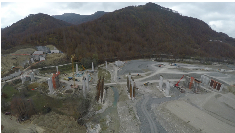
Fotografija sa terena gradilišta auto-puta
