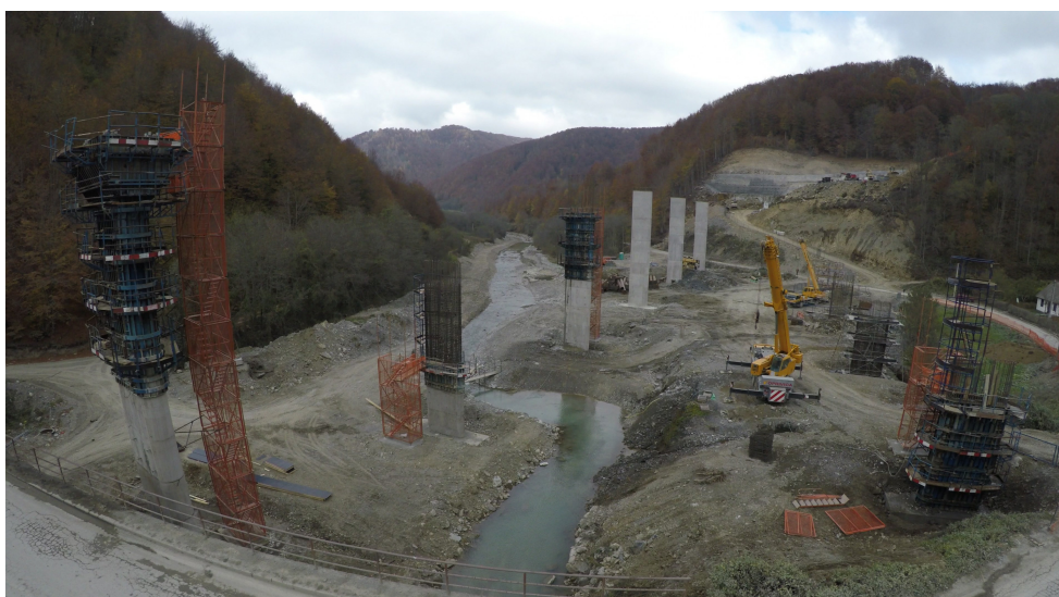
Fotografija sa dijela gradilišta auto-puta Bar-Boljare
