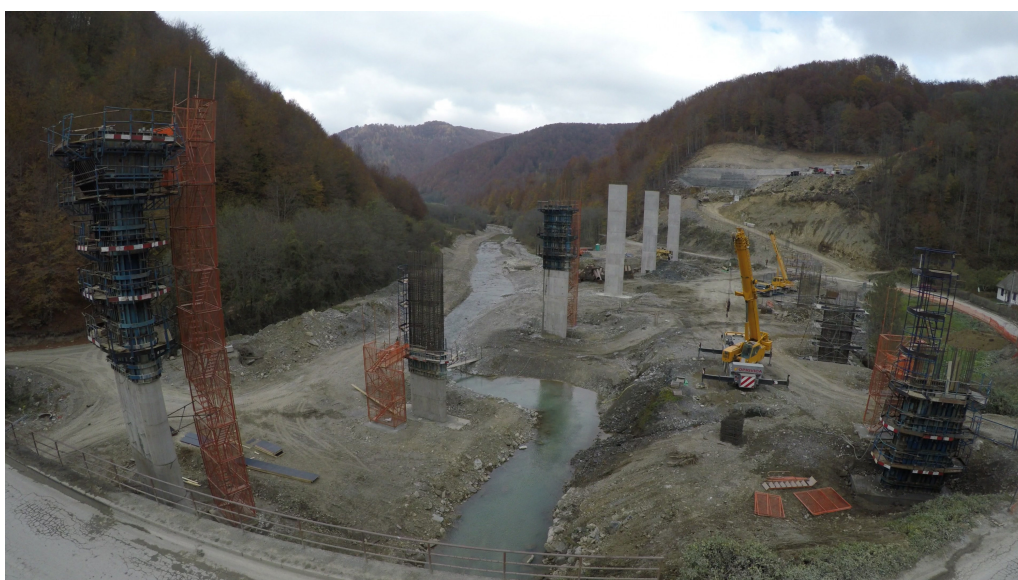
Fotografije sa dijela gradilišta auto-puta (regulacija toka rijeke Tare)
