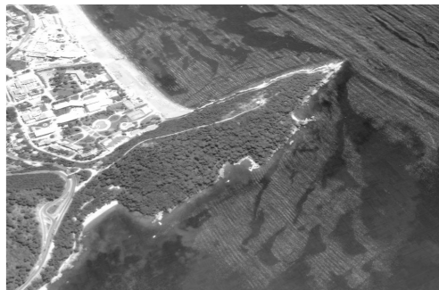
Rt Zavala prije početka gradnje
