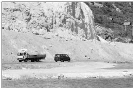
Nasip u moru na lokaciji Lipci
