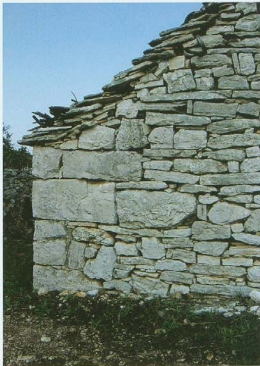
Ugao i struktura zida suhozidne kućice.
