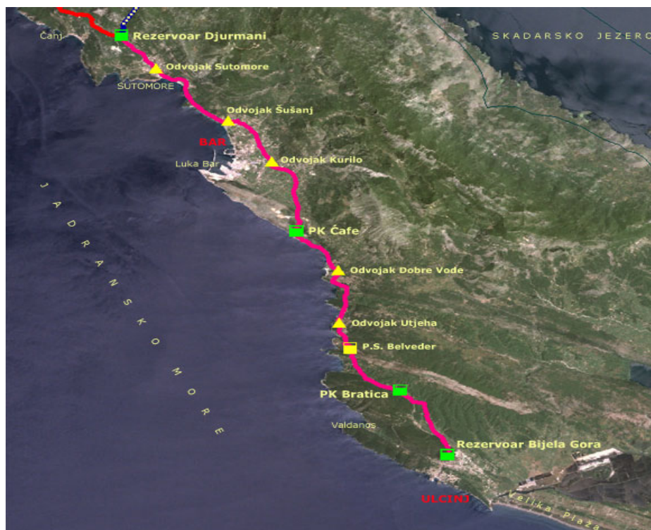
Slika 7. Južni krak regionalnog vodovoda
