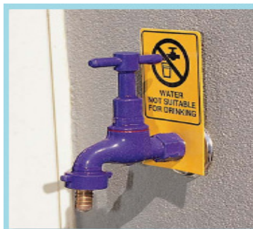
Sistemi sa prerađenom vodom Mawson Lakes, Južna Australija
