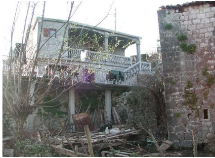
Rekonstruisana kuća na obali sa starim zidom i stubovima u prizemlju
