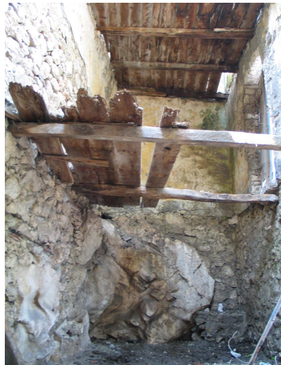
Ostaci drvene međuspratne konstrukcije
