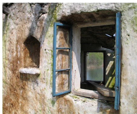
Detalj prozora u prizemlju sa unutrašnje strane
