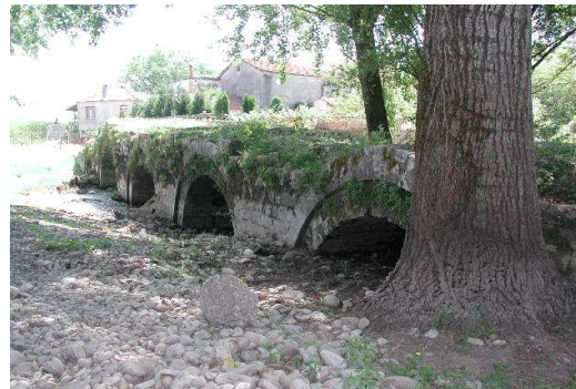
Cukalj-kameni most na pet svodova
