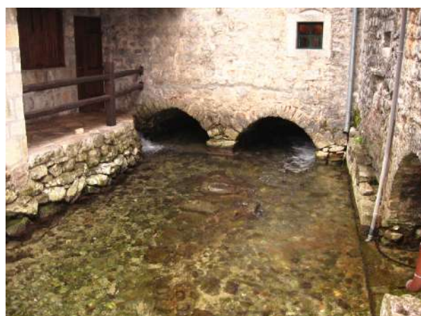
Kanali za vodu u prizemlju
