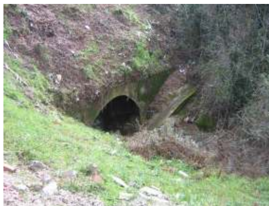
Sl.6. Potok K2, propust ispod magistrale
