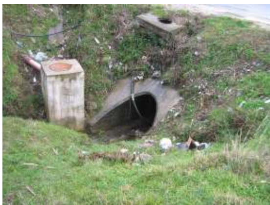
Sl. 5. Potok K1 – Banićevina, propust
