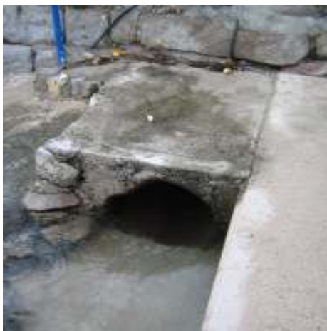
Sl. 15. Propust ispod puta uz more
