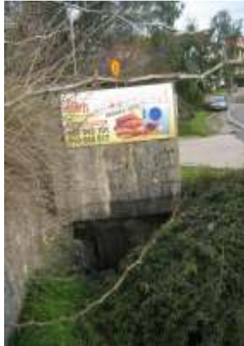
Sl. 11. K5, Uzvodno od magistrale, Sl. 12. Izlaz K5, iz zatvorenog profila u otvoreni (1,40 x 1,20 m)
