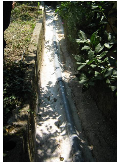
Slika 10. Betonsko korito u nizvodnom dijelu trase sa plastičnom cijevi
