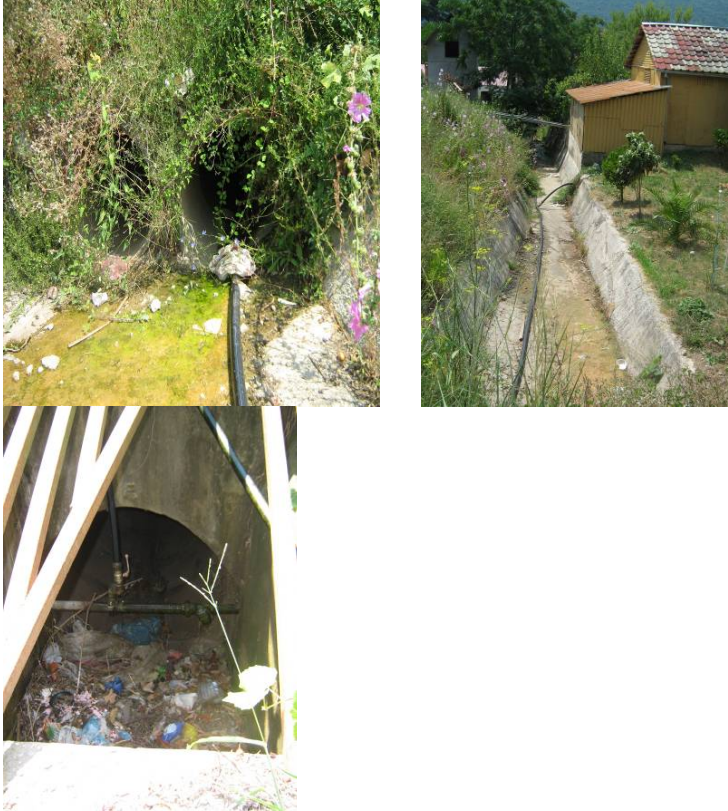
Slika 11, 12, 13. - Potok „K6“ – spoj dva korita, betonsko trapezno korito i betonski propust u obliku poluelipse, ispod obilazne saobraćajnice.
