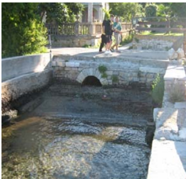
Slika 5,6,7. – Primjeri propusta kišnih kanala kroz priobalnu saobraćajnicu
