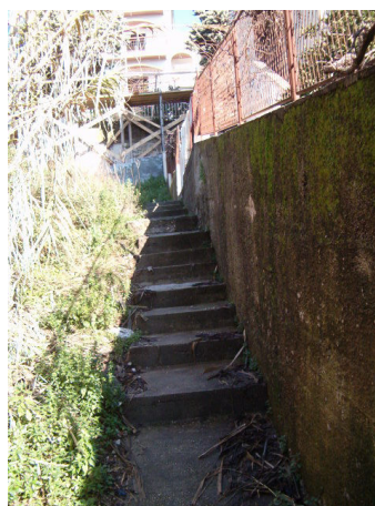
Sl.6. Stepenište koje se pruža pravcem Sjever-jug, desno se vidi vlaga na zidu
