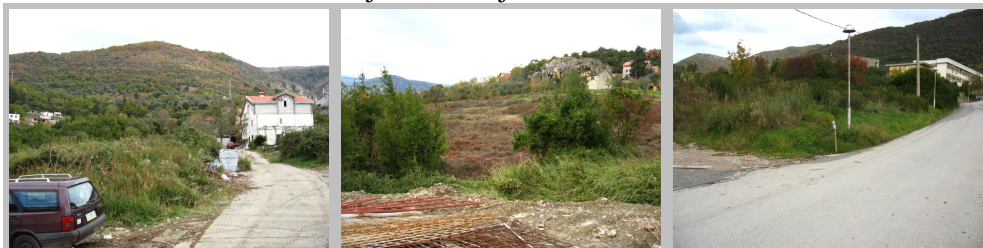
Slika br.10. Fotodokumentacija sa lokacije
