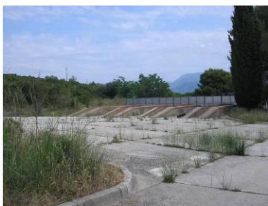
Objekat br. 3 – postojeći objekat, rampe za servisiranje vozila
