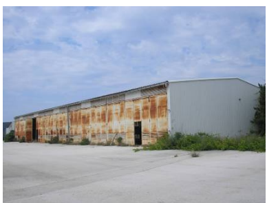
Objekat br.6 – postojeći montažni objekat, hala, ruiniran. Spratnost objekta je visoko prizemlje, a bruto građevinska površina 961 m 2 .
