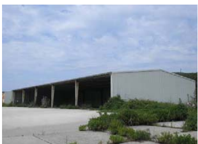
Objekat br. 5 – postojeći montažni objekat, hala, ruiniran. Spratnost objekta je visoko prizemlje, a bruto građevinska površina 970 m 2 .
