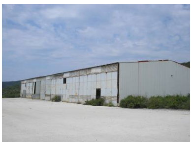
Objekat br.7 – postojeći montažni objekat, hala, ruiniran. Spratnost objekta je visoko prizemlje, a bruto građevinska površina 968 m 2 .
