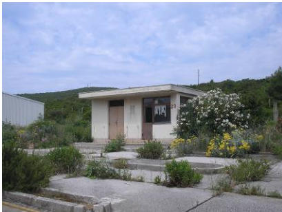
Objekat br. 3 - postojeći objekat, rampe za servisiranje vozila
