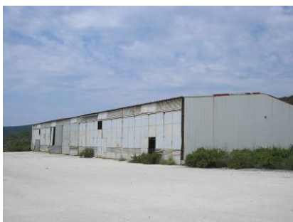
Objekat br. 6 - postojeći montažni objekat, hala, ruiniran. Spratnost objekta je visoko prizemlje, a bruto građevinska površina 961 m 2 .
