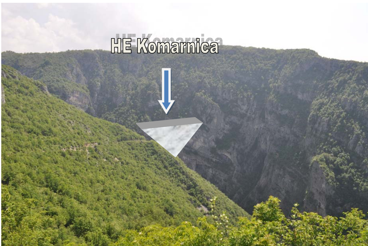
Fotografija 1: Približna mikrolokacija lučne betonske brane HE Komarnica
