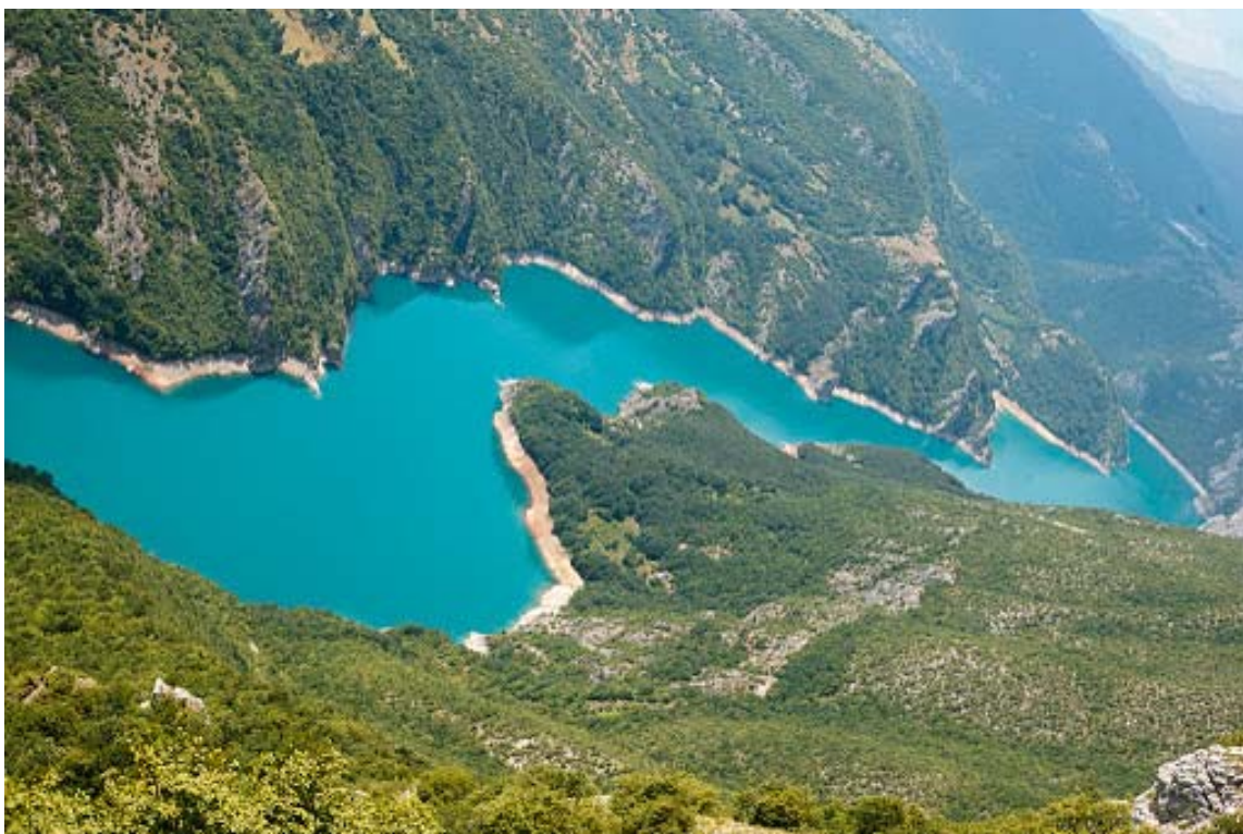
Fotografija 9: Pivsko jezero – hidroakumulacija elektrane Mratinje
