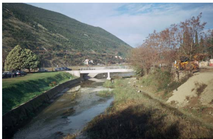
Slika 19. Rijeka Sutorina, nizvodno od predmetne lokacije
